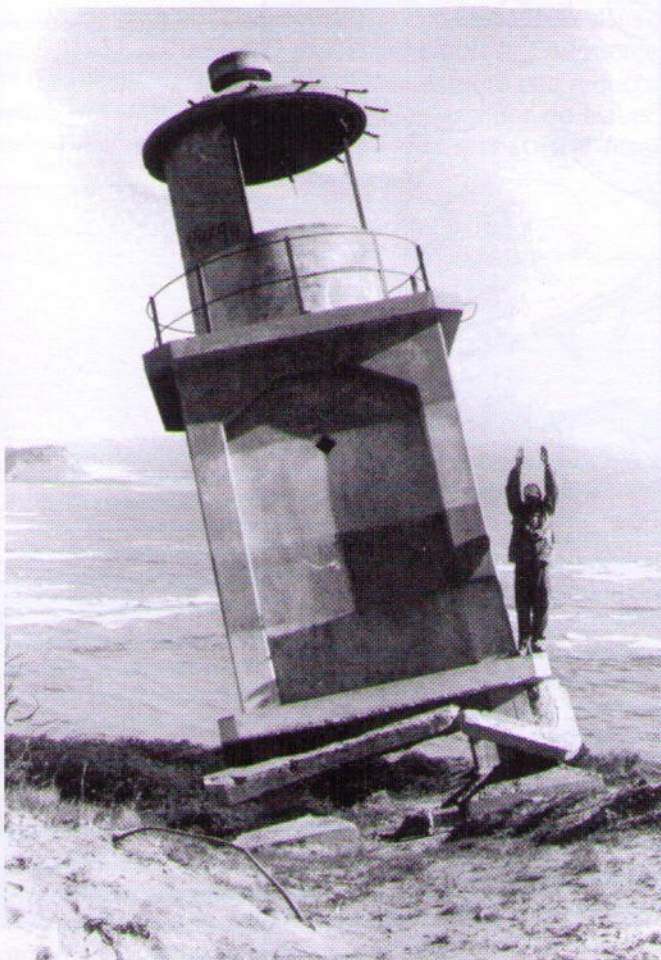
Figura 4. El Faro del Cabo San Pablo se inclinó unos 15 grados como consecuencia del terremoto de 1949.
